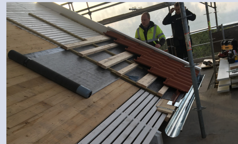
Referencebillede fra anden tagrenovering. Opbygning af tag.
