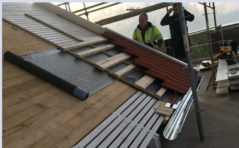
Referencebillede fra anden tagrenovering. Opbygning af tag.
